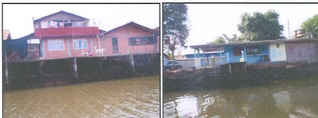
Figura 47 – Ocupação irregular na margem esquerda do Rio Perequê reportada em 2007.
