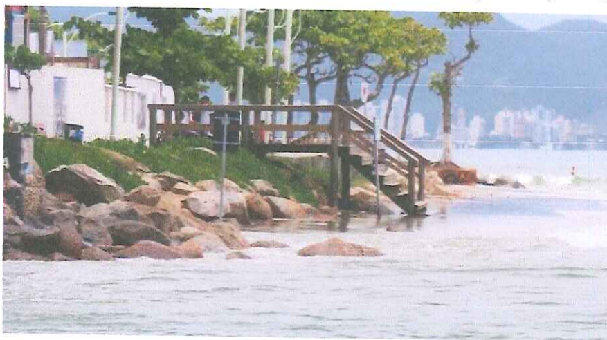
Figura 41 - Enrocamento realizado de forma paliativa na foz do Rio Perequê no município de Itapema tendo em vista a contenção dos processos de erosão praial já comumente observados. Fonte: OAP Consultores Associados.
