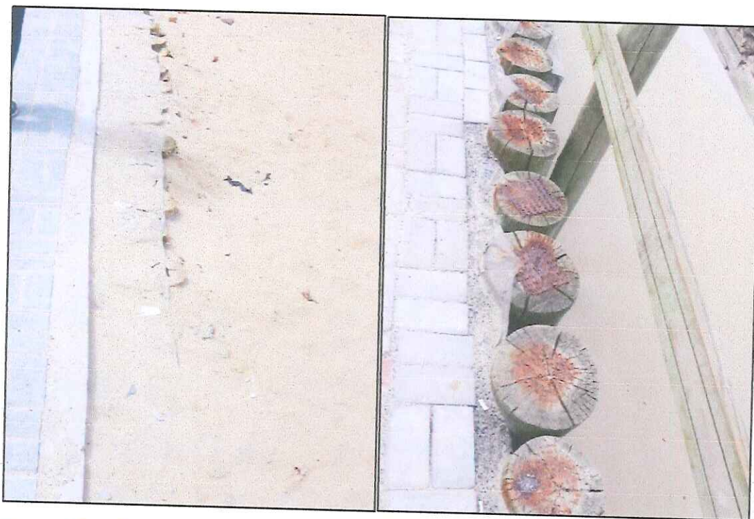
Figura 43 - Contenção implantada na orla do município de Itapema tendo em vista a minimização dos impactos ocasionados pela erosão costeira no Parque Linear implantado. Fonte: AMFRI, 2019.
