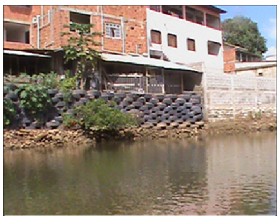
Fotografia 3 – Ocupação desordenada sobre APP do rio Reis Magos e contenção da margem com pneus (fonte: Projeto Orla, abril de 2010).
