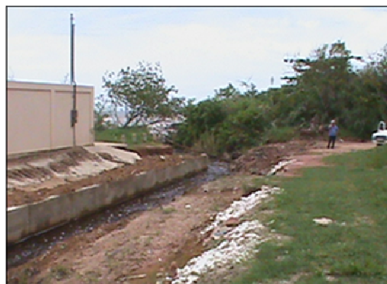
Fotografia 44 – Desvio de córrego de drenagem de águas pluviais por avanço de construção sobre APP, causa erosão e obstrução de via pública (Av. Rouxinol) no loteamento Enseada das Garças (fonte: Projeto Orla, março de 2010).
