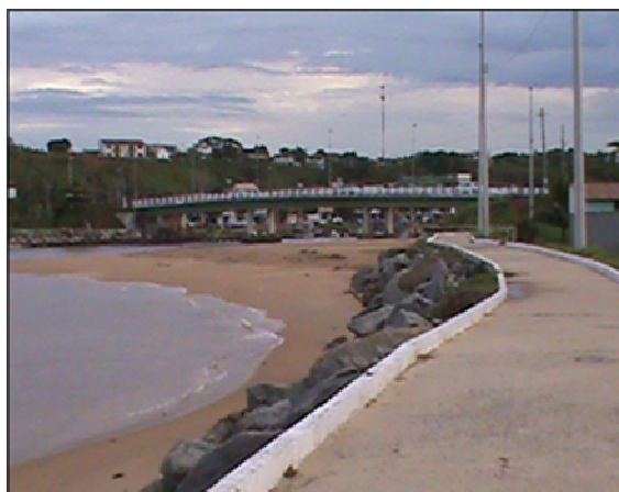
Fotografia 12 – Calçada sobre enrocamento reforçado com pedras e ao fundo a ponte Flodoaldo Borges Miguel sobre o rio Reis Magos (fonte: Projeto Orla, março de 2010).
