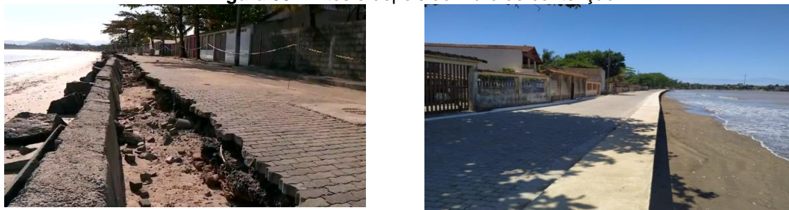
Figura 39: Antes e depois do muro de contenção.
