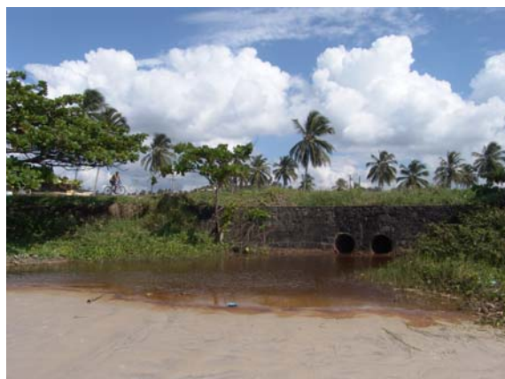
Rede de drenagem com esgoto lançado na areia Foto: Ferreira, Ed
