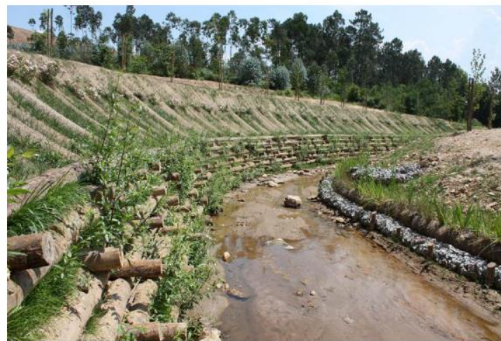
Figura 50. Na margem esquerda muro de suporte vivo parede dupla com plantio de arbustos autóctones e feixes vivos, biomanta de coco e hidrosseadura e na direita gabião cilíndrico preenchido com pedra e biorretenor de coco vegetado, Ribeira de Gende, Portugal (Projeto Rita Sousa, foto: Rita Sousa, 2011).
