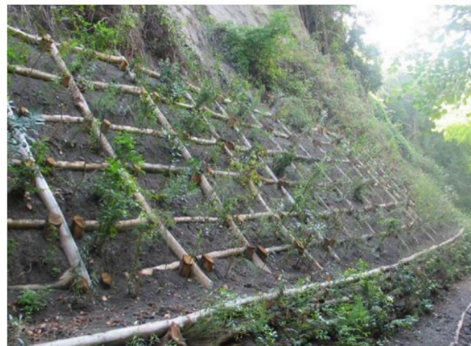
Figura 54. Muro de suporte vivo parede dupla combinada com grade viva, Parque Nacional do Vesúvio, Itália (Projeto: Gino Menegazzi, foto: Rita Sousa, 2023).
