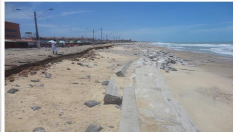
FIG. 5: Bagwall ou tubos de geotêxtil como caracterizado pelos empreendedores, esta estrutura foi danificada e ficou na praia de Icarai, Caucaia/CE. Fonte: ICP nº 1.15.000.002630/2013-63
