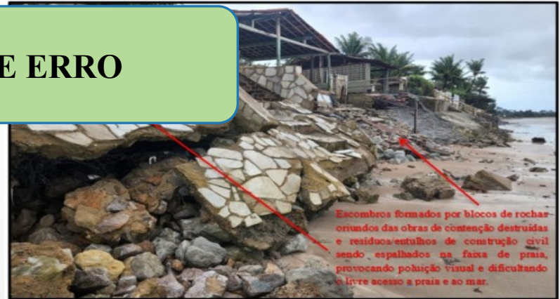
FIG. 4: Estruturas rígidas e obras de proteção costeira construídas em faixa de praia. Estas construções favorecem a erosão na face da praia e possuem baixa eficiência na proteção contra alta hidrodinâmica. Fonte: ICP nº 1.24.000.000431/2022-01.
