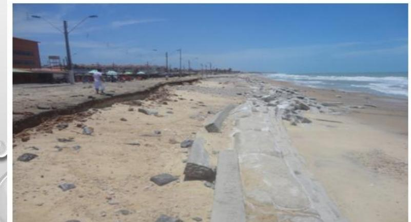
FIG. 5: Bagwall ou tubos de geotêxtil como caracterizado pelos empreendedores, esta estrutura foi danificada e ficou na praia de Icaraí, Caucaia/CE. Fonte: ICP nº 1.15.000.002630/2013-63
