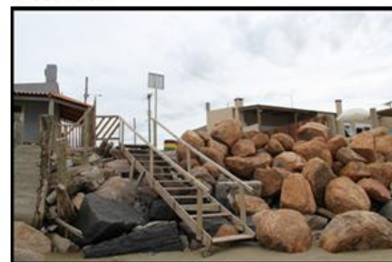
FIG. 05 – Enrocamento lançado (vide Anexo I). Fonte: SEAP.
