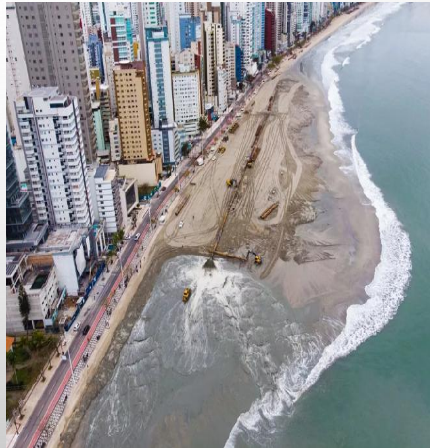
Engordamento Praia Central, Balneário Camboriú/SC
