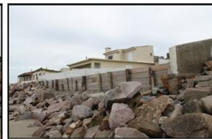
FIG. 06 – Enrocamento lançado (vide Anexo I). Fonte: SEAP.
