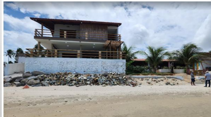
Figura 24: Ocupação em faixa com obra de enrocamento lançado. Fonte: MPF.
