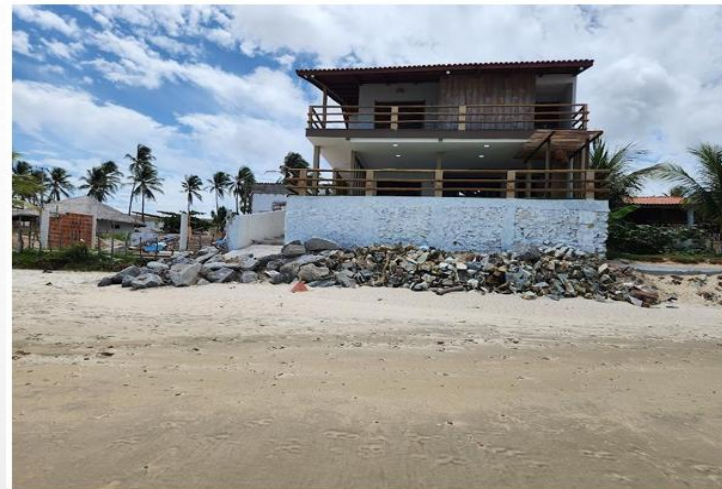
Figura 24: Ocupação em faixa com obra de enrocamento lançado. Fonte: MPF.
