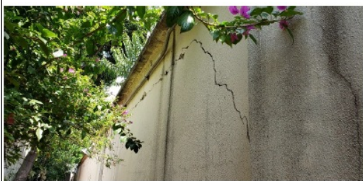
Foto 10 – Trinca severa no muro de divisa
