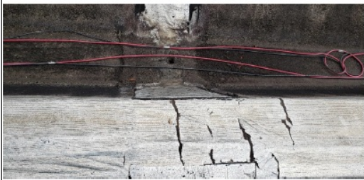
Foto 08 – Impermeabilização danificada
