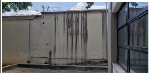
Foto 16 – Fissuras e danificação de reboco e pintura
