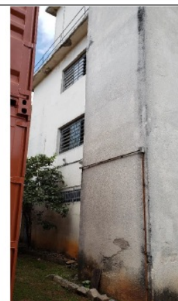
Foto 06 – Desagregação de reboco
