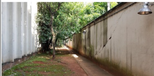
Foto 11 – Trinca severa no muro de divisa
