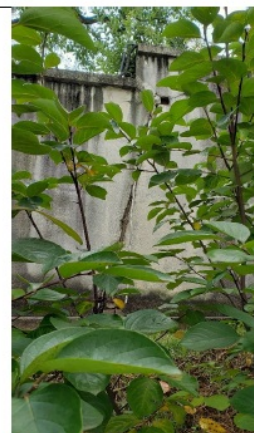
Foto 07 – Trinca severa no muro de divisa
