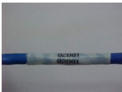
Modelo de identificação dos cabos lógicos.
