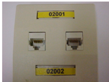
Modelo de identificação na caixa de tomada RJ45.
