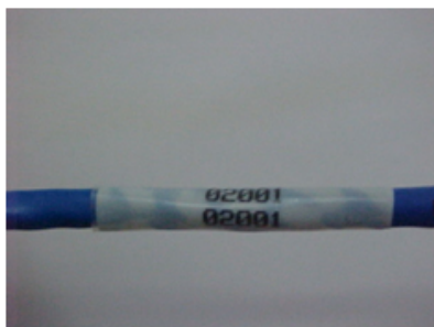
Modelo de identificação dos cabos lógicos.
