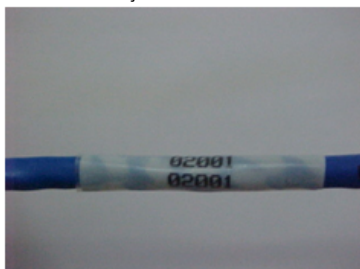
Modelo de identificação dos cabos lógicos.
