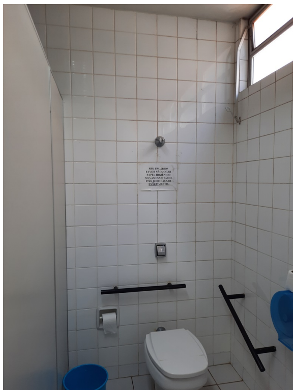
Barras existentes a retirar pois estão fora das normas.
