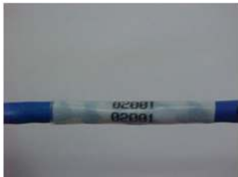
Modelo de identificação dos cabos lógicos.
