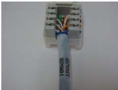
Modelo de identificação próximo à tomada RJ45 fêmea
