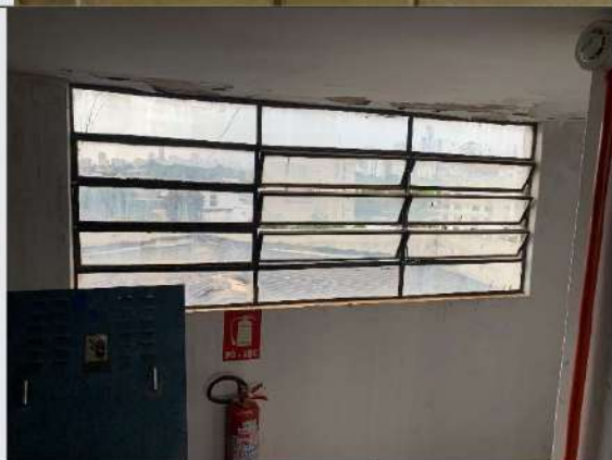
Foto SRT05.3/1 – Elevadores, INSPEÇÃO: CASA DE MÁQUINAS
