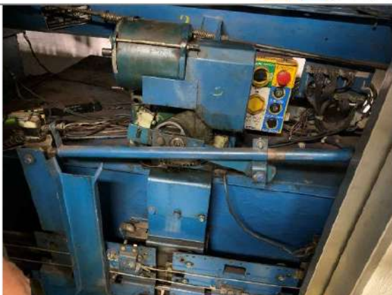
Foto SRT10.3/1 - Elevadores, INSPEÇÃO: TOPO DE CABINE
