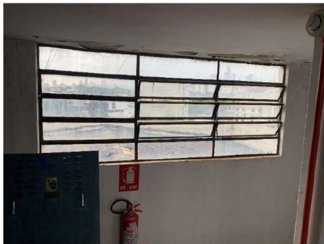
FOTO 15 – CASA DE MÁQUINAS DOS ELEVADORES
