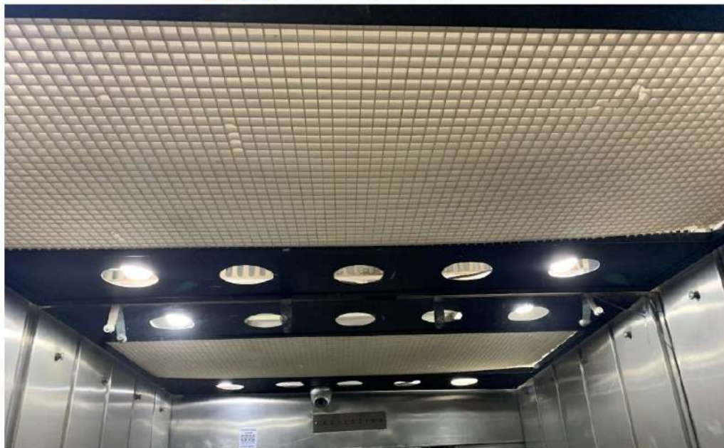
FOTO 12 – SUBTETO DE CABINE
