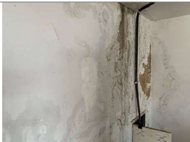
Foto SRT07.3/1 – Casa de Máquinas, INSPEÇÃO: REVESTIMENTO INTERNO
