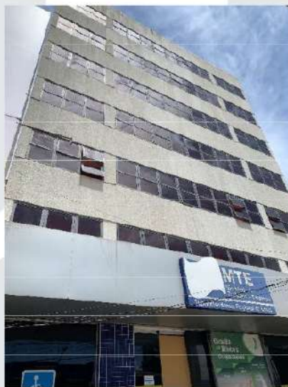
FOTO 01 – Prédio Sede da Superintendência Regional do Trabalho de Goiás/Tocantins em Goiânia/GO.
