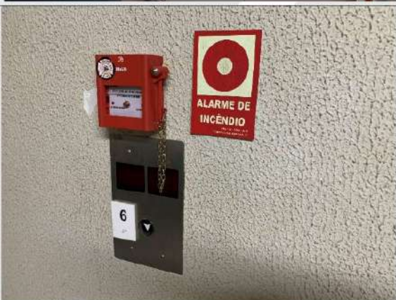
Foto SRT06.3/1 – Elevadores, INSPEÇÃO: HALL DOS ELEVADORES
