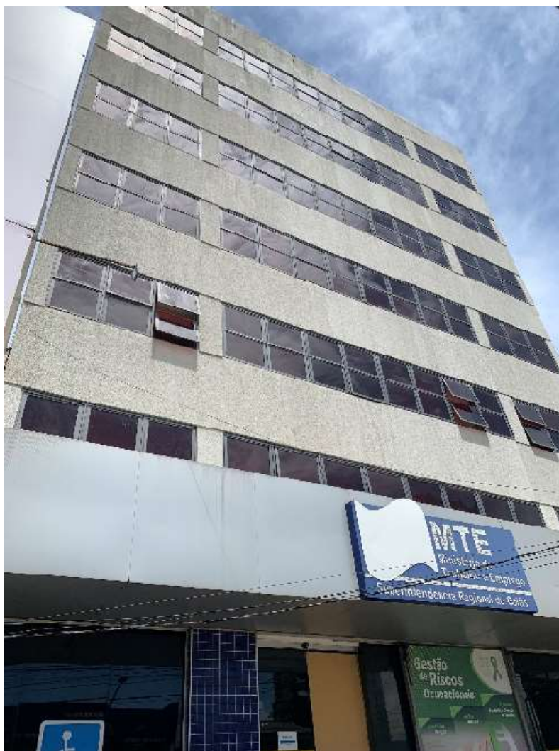
FOTO 01 – Prédio Sede da Superintendência Regional do trabalho em Goiás
