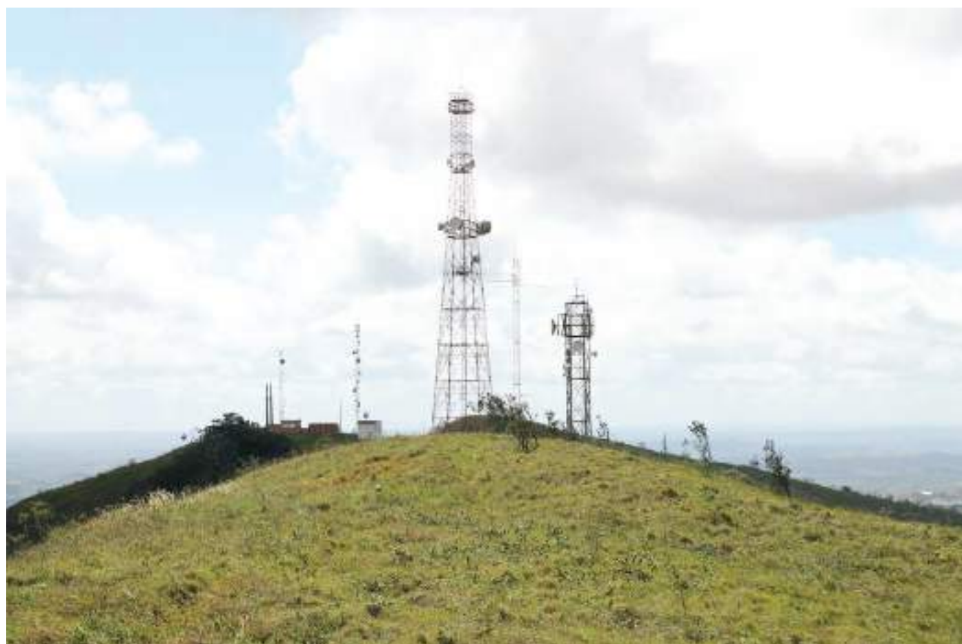
A instalação no alto das serras de torres metálicas com antenas de comunicação interferem na conservação da paisagem do Parque Nacional Serra de Itabaiana. Foto: Neison Freire (2015).
