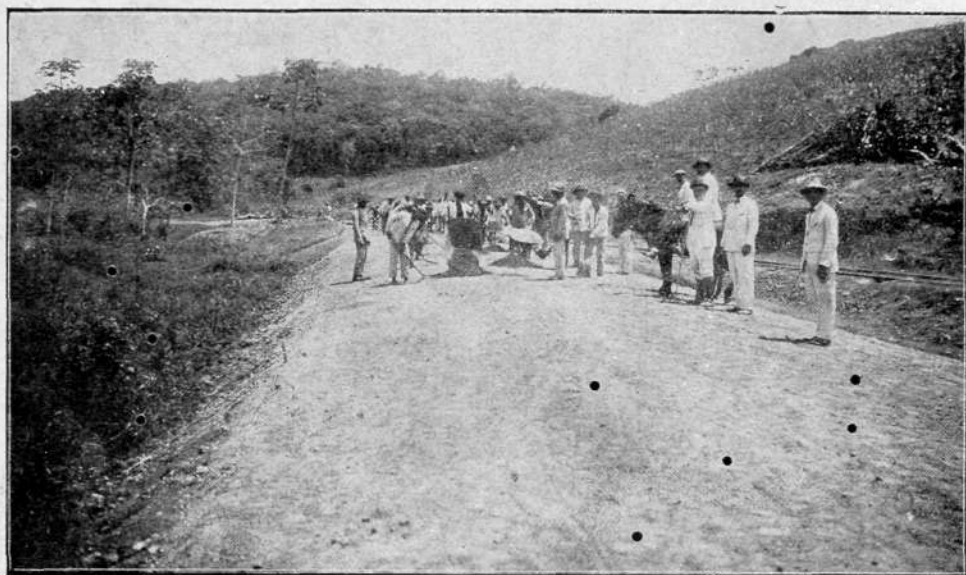
Trecho em construção em Montevideo—Ipojuca
