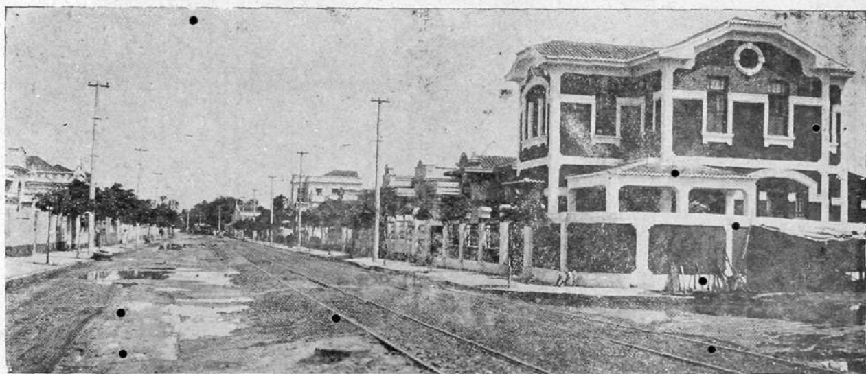
Trecho da linha "Bepinheiro" recentemente inaugurada
