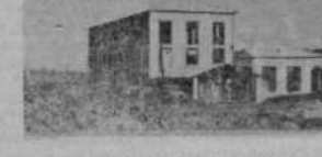
Fachada principal da usina "São Francisco"
