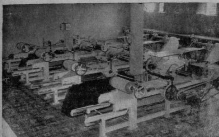
As quatro estampadoras de biscoitos, motoriza das, com cilindros reversíveis e mesas móveis.
