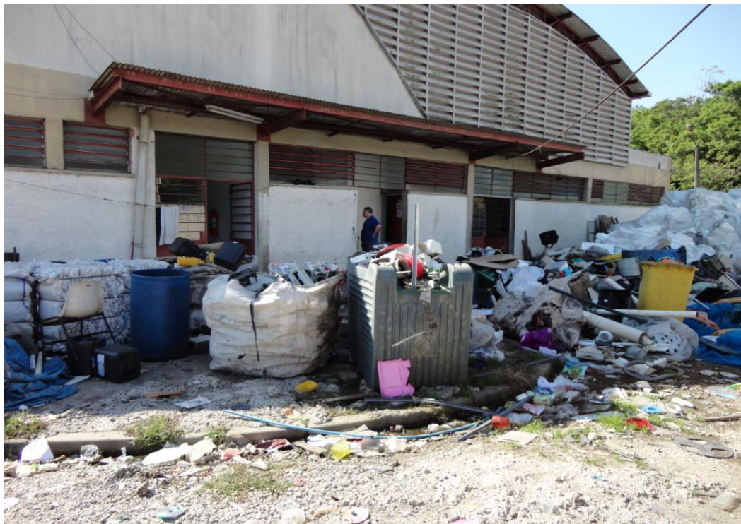
Àrea externa do galpão
