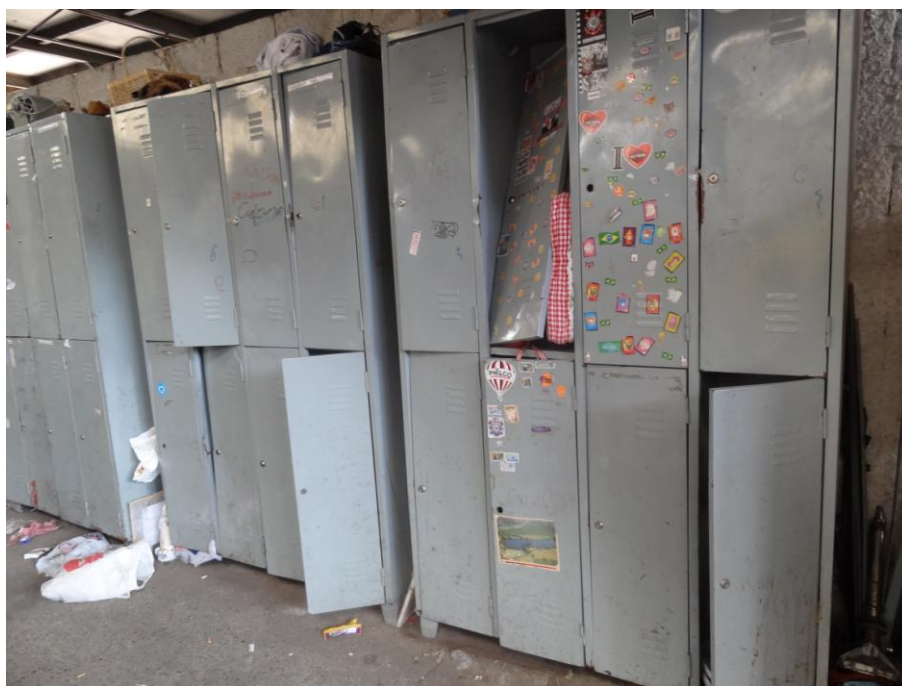
Armários em precário estado de conservação
