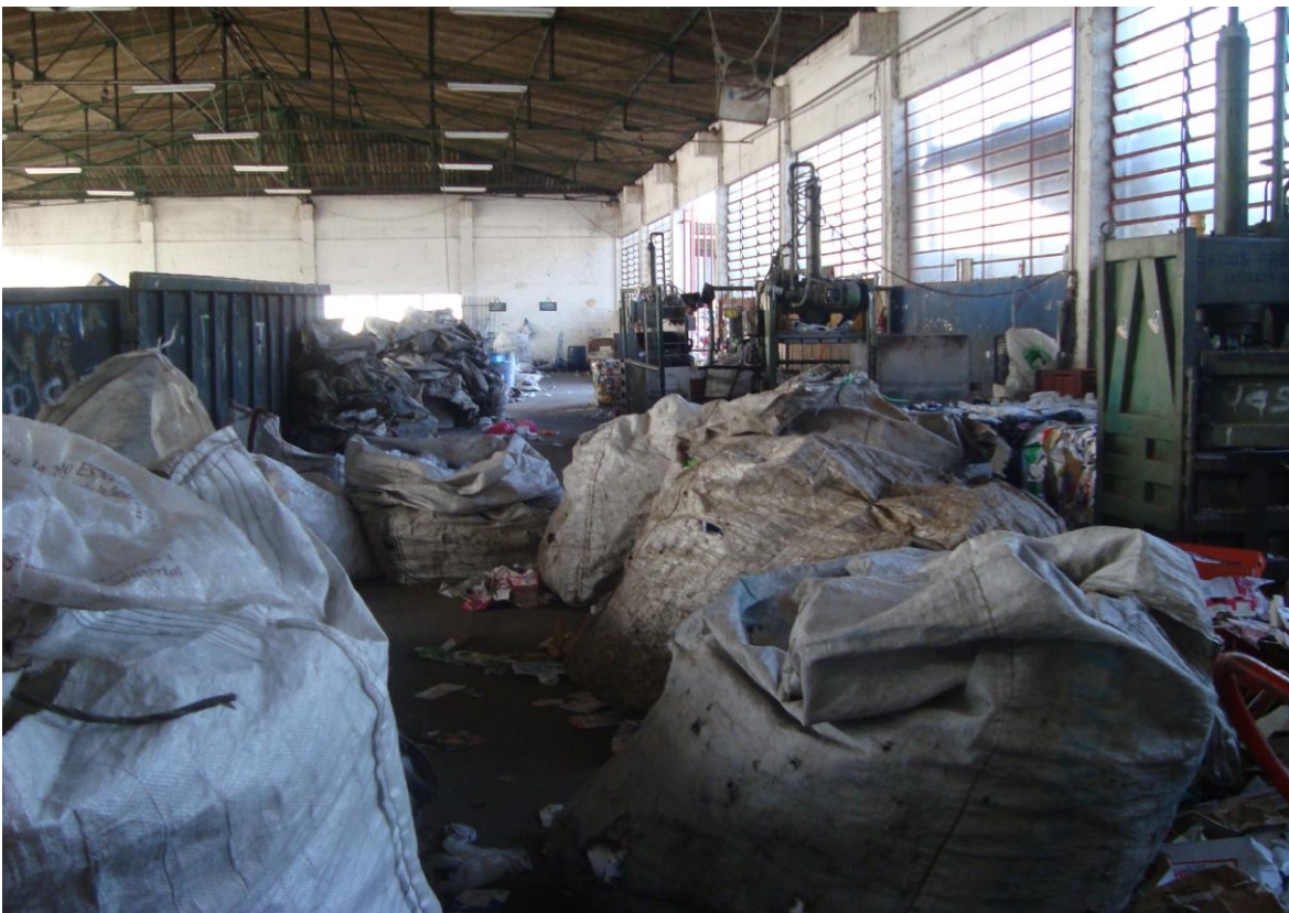
Galpões de triagem de resíduos sólidos recicláveis
