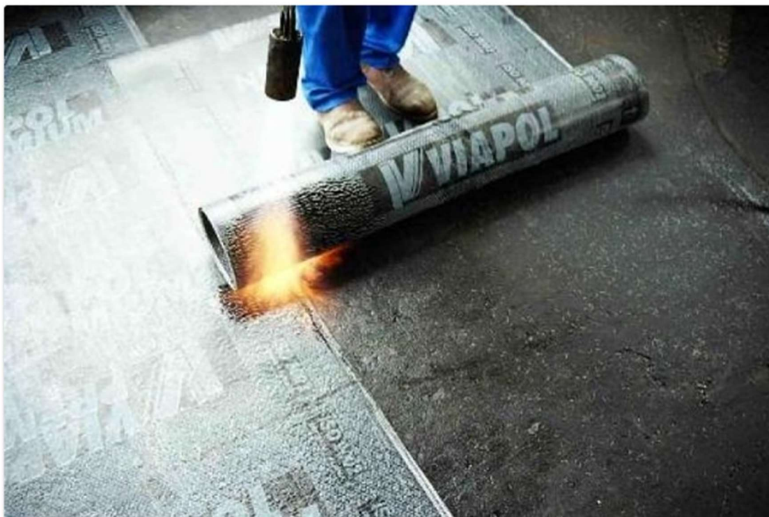
Impermeabilização de lajes utilizando-se manta asfáltica (Fonte: Construindo Decor )
