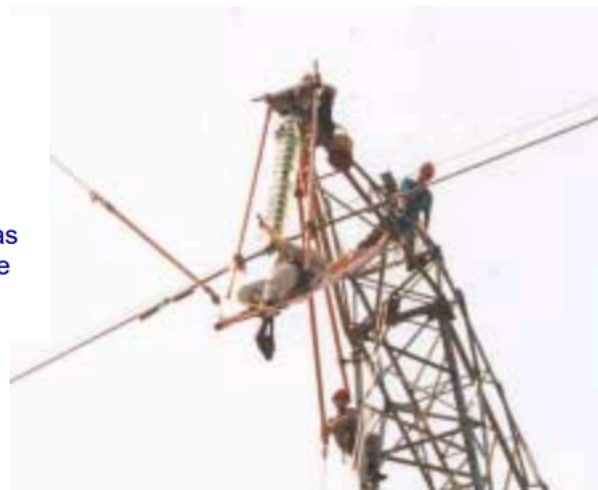
Reparo em isolador – linha de transmissão 230 Kv
