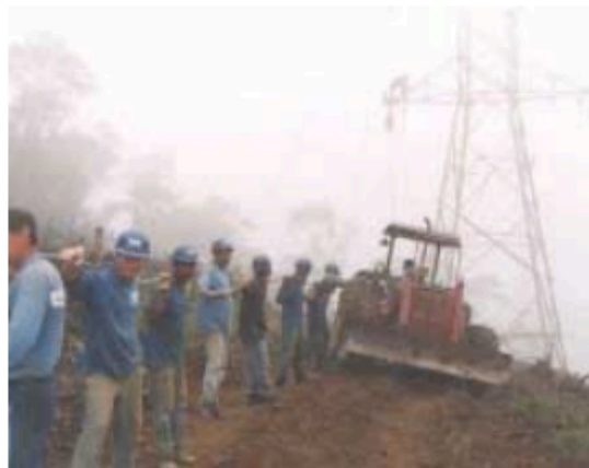
Lançamento de cabos
