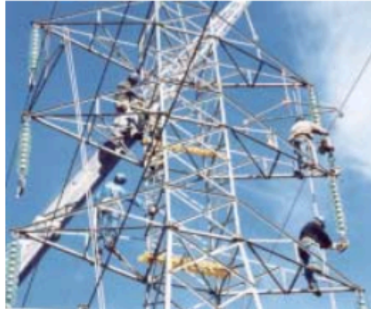
Instalação dos acessórios na construção de torres de transmissão
