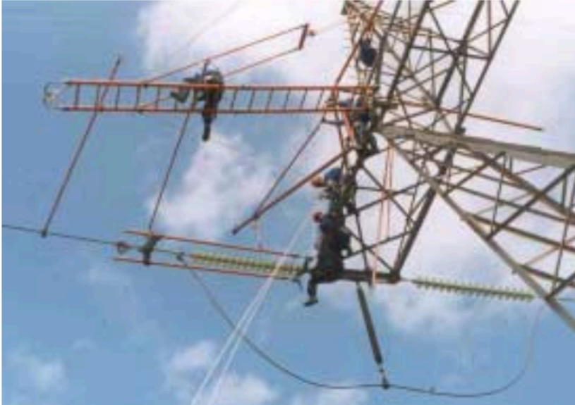
Troca de isolador em linha de transmissão de 138 KV - linha “viva”, método à distância
