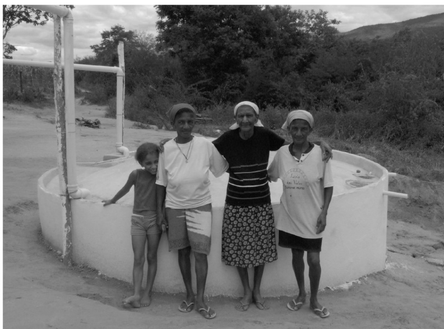
Figura 7 - Cisterna de captação de água das chuvas aperfeiçoada, comunidade Mutuca de Cima (Município Coronel Murta)
