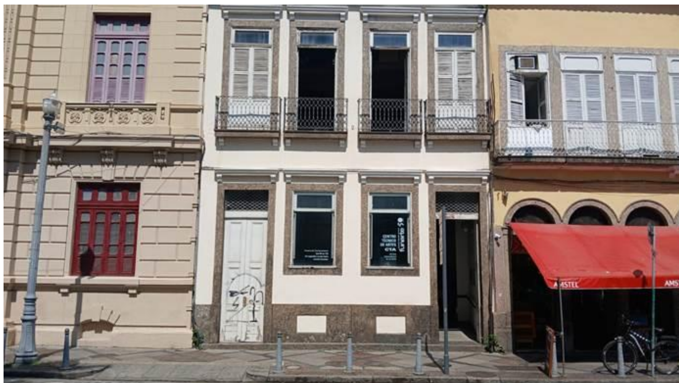
Fachada do Centro Técnico de Artes
