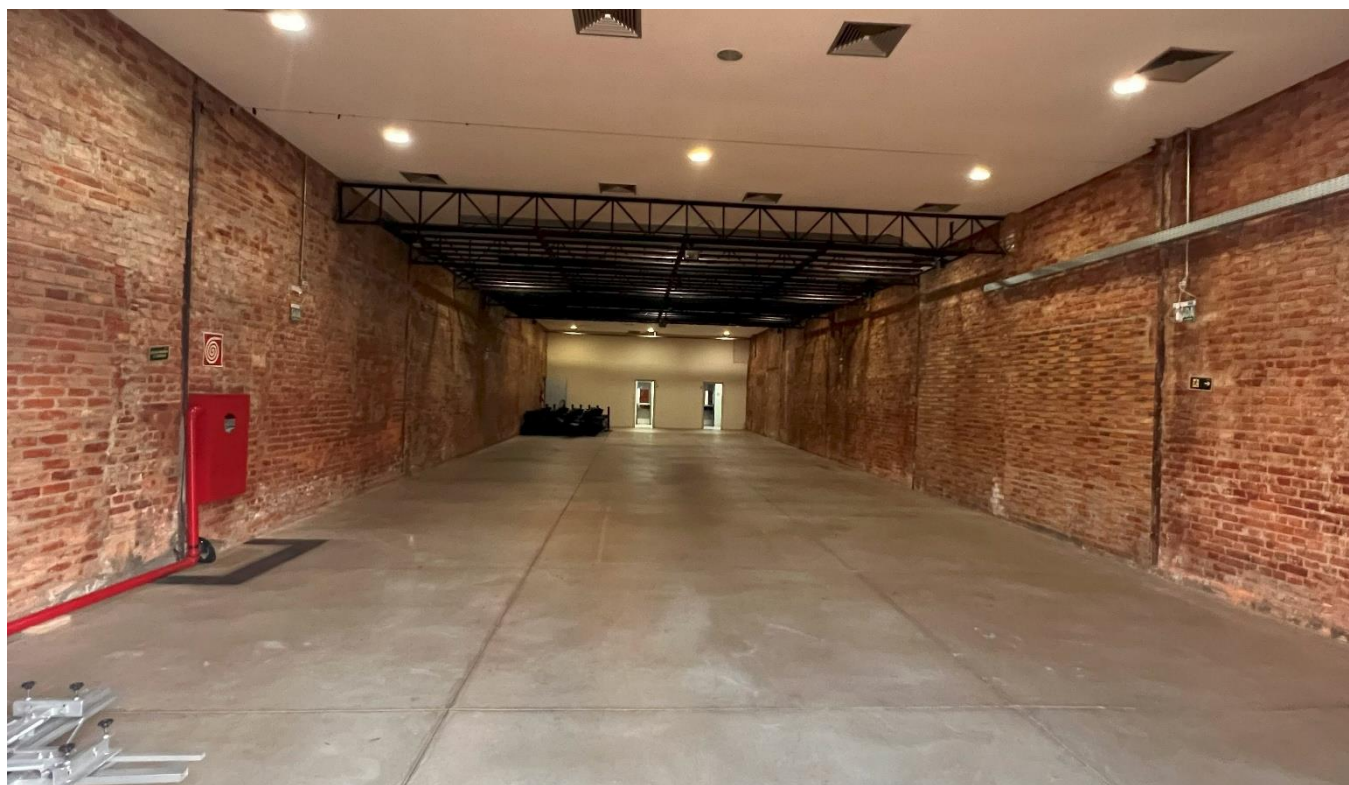
INTERIOR DO GALPÃO 04
