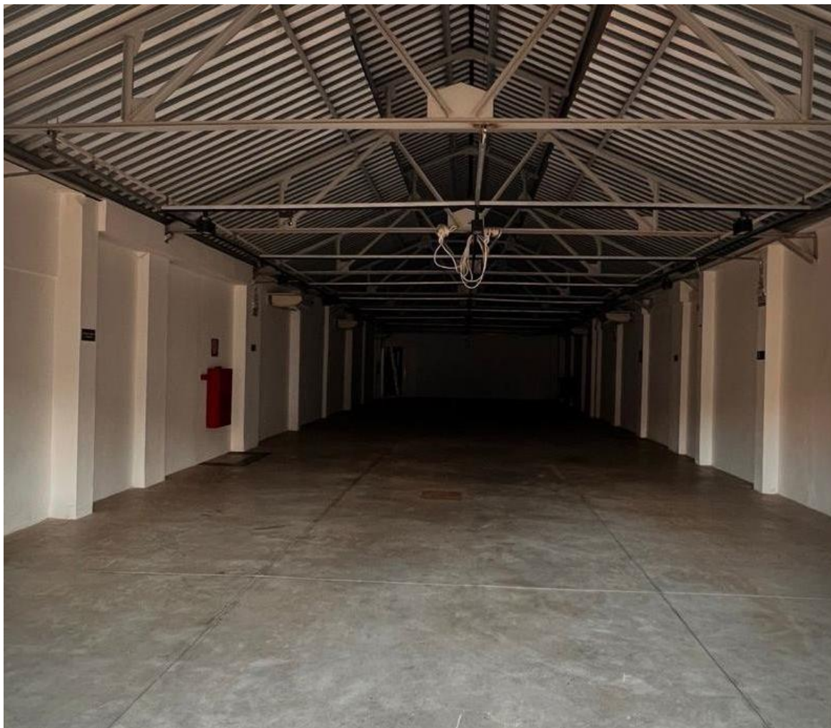
INTERIOR DO GALPÃO 05
