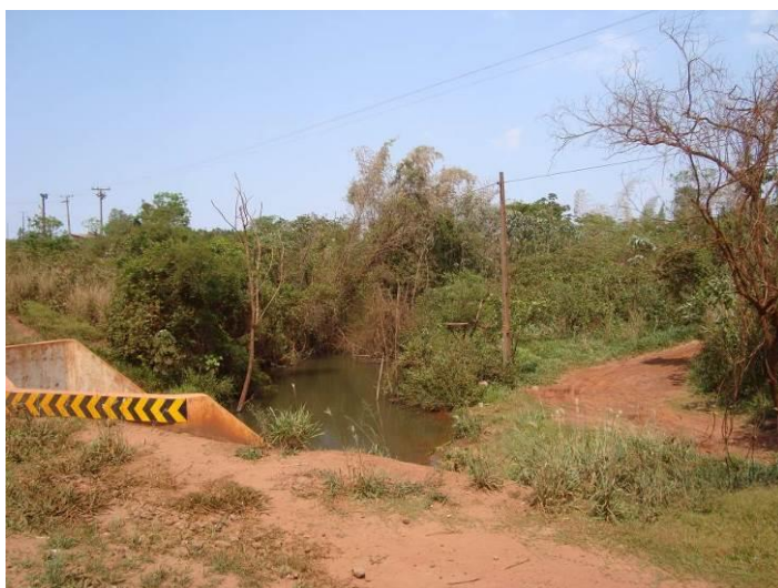
Figura 82 - Ponte no Córrego Taquara a 1km da cidade de Laguna Caraapã.
