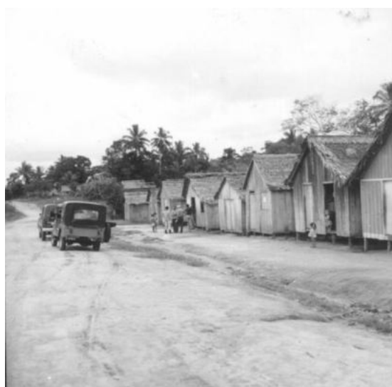
Foto 69 - Casas da Colônia Japiim - 1974 - Fonte IBGE
