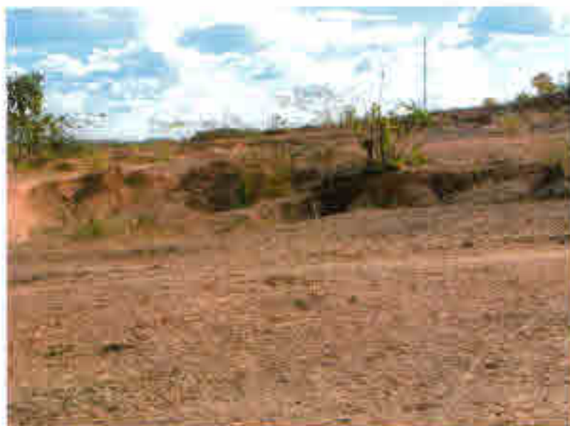
Processos erosivos (ravinas) aldeia Custódio – julho de 2009. Autor: Paulo Emílio Gomes Nobre
