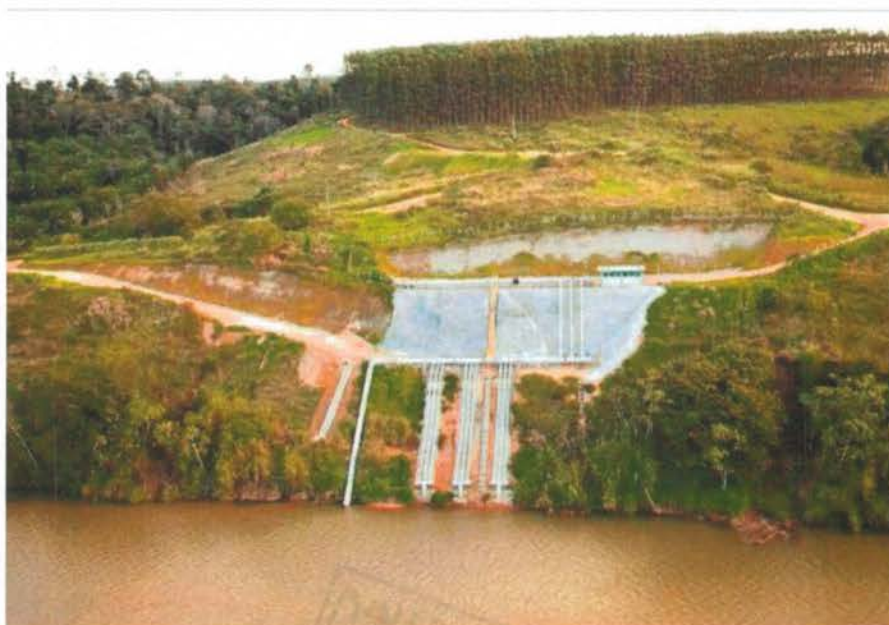
FIGURA 41 Sistema de emissários subaquáticos de lançamento de efluente da fábrica no rio Jequitinhonha. Fonte: EIA/RIMA Ampliação da Fábrica da Veracel.
