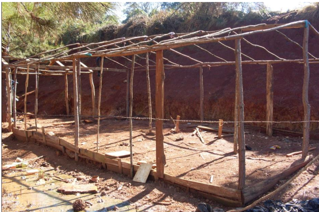
Figura 48: Estrutura de uma habitação de duas águas, com madeira, própria dos acampamentos reivindicatórios – acampamento “do alto” de Mato Castelhana, julho de 2009.
