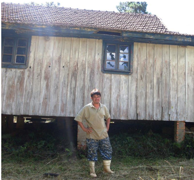
Figura 116: J6 Reis mostrando as casas desabitadas dos antigos gestores da FLONA – julho de 2009.
