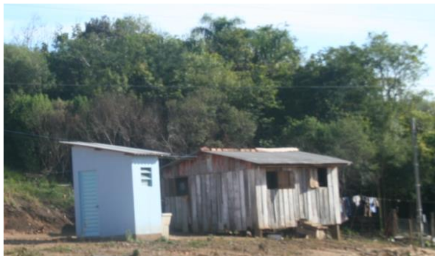
Figura 52: Módulo sanitário da FUNASA e habitação, TI Carreteiro – julho de 2009.
