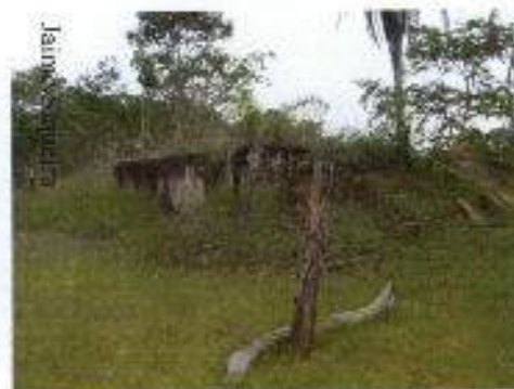
Figura 35 Escombros do antigo prédio do SPI
