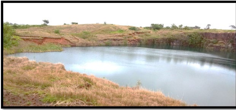
Figura 19 - A pedreira que desmoronou – (Fazenda Serrana)
