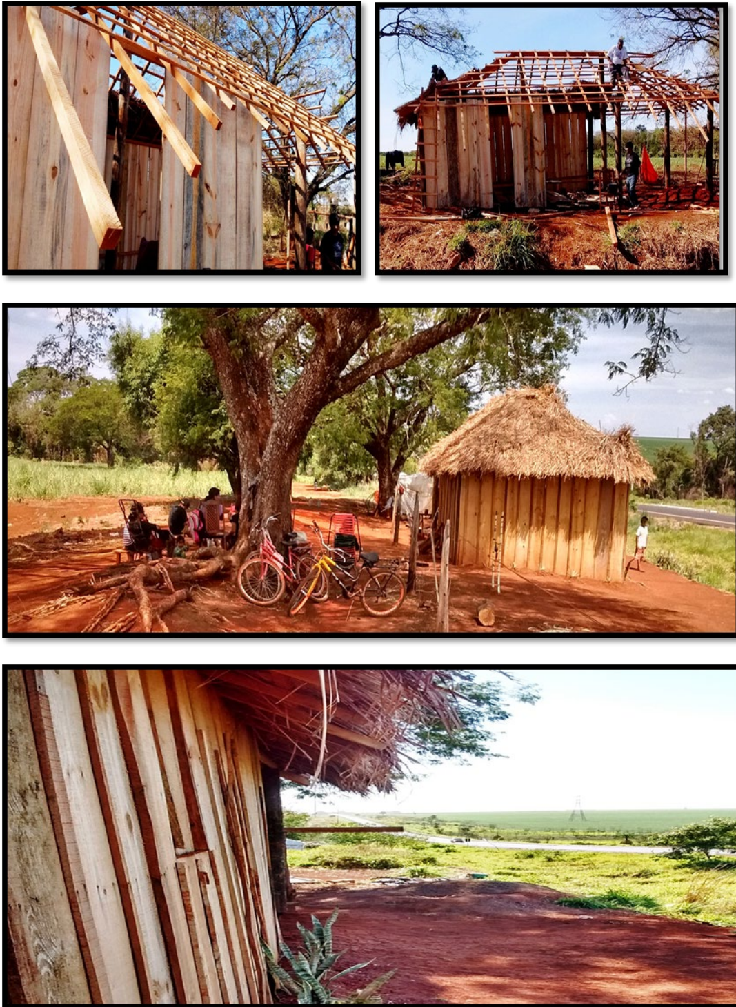
Figura 10 - Construção atual de casa tradicional no acampamento do Apyka'i.
