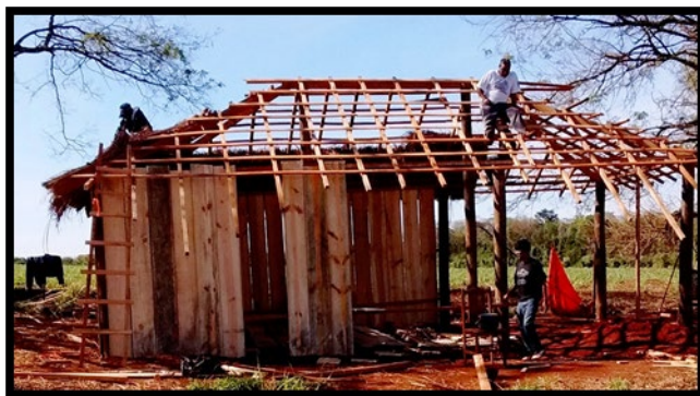
Figura 28 - Construção de casa no acampamento da margem da BR 463.
