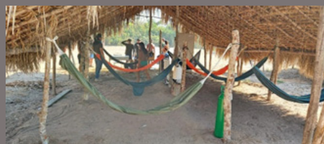
Construção de edificação tradicional temporária para Isolamento (Covid19) - Povo Enawenê-Nawê
