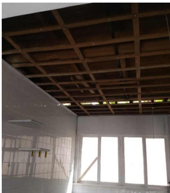
Foto 1: Troca dos telhados das áreas técnicas
