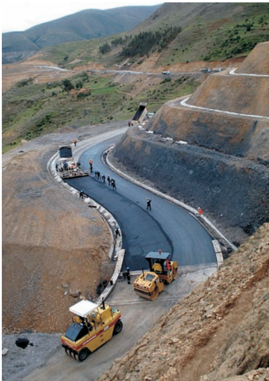
Obras em execução na IIRSA SUL, Trecho 2, no Peru
