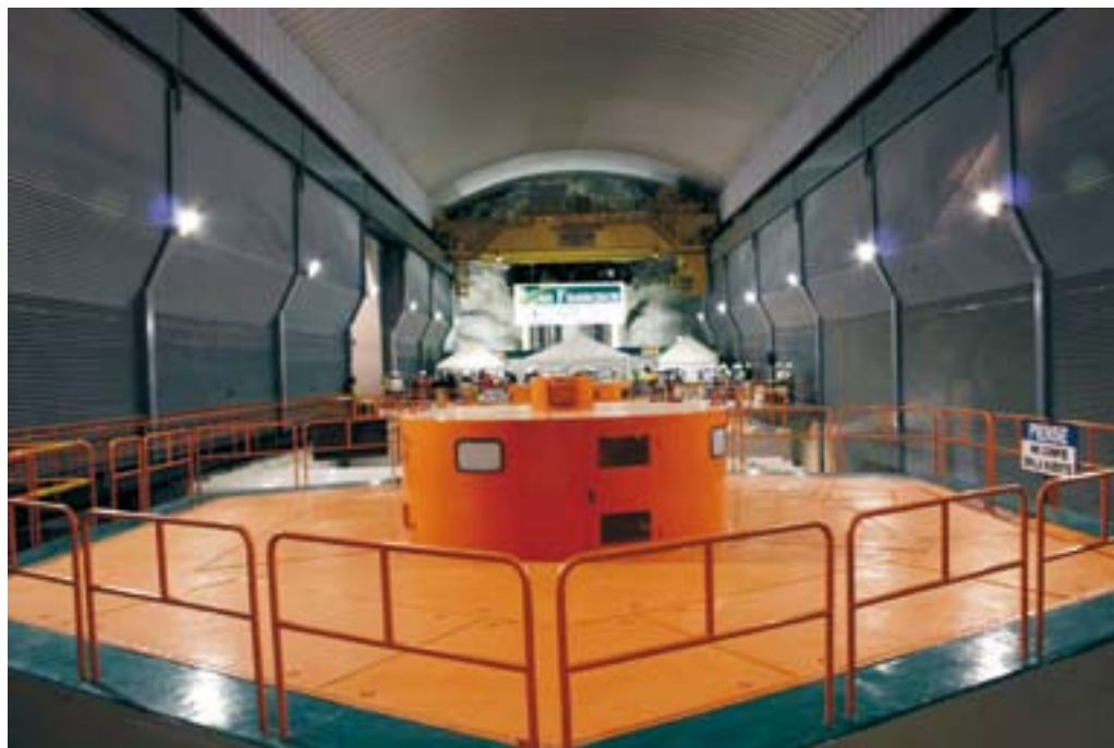
Usina hidrelétrica San Francisco (Equador)
