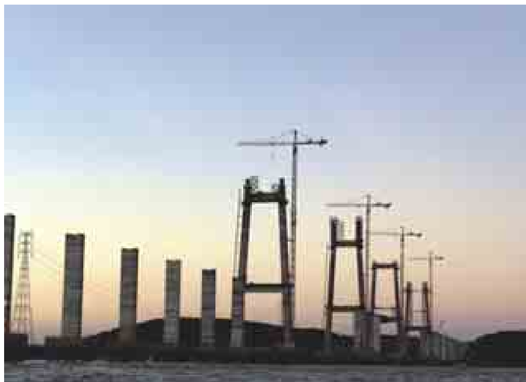
Sistema Viário e Ponte Mista sobre o Rio Orinoco
