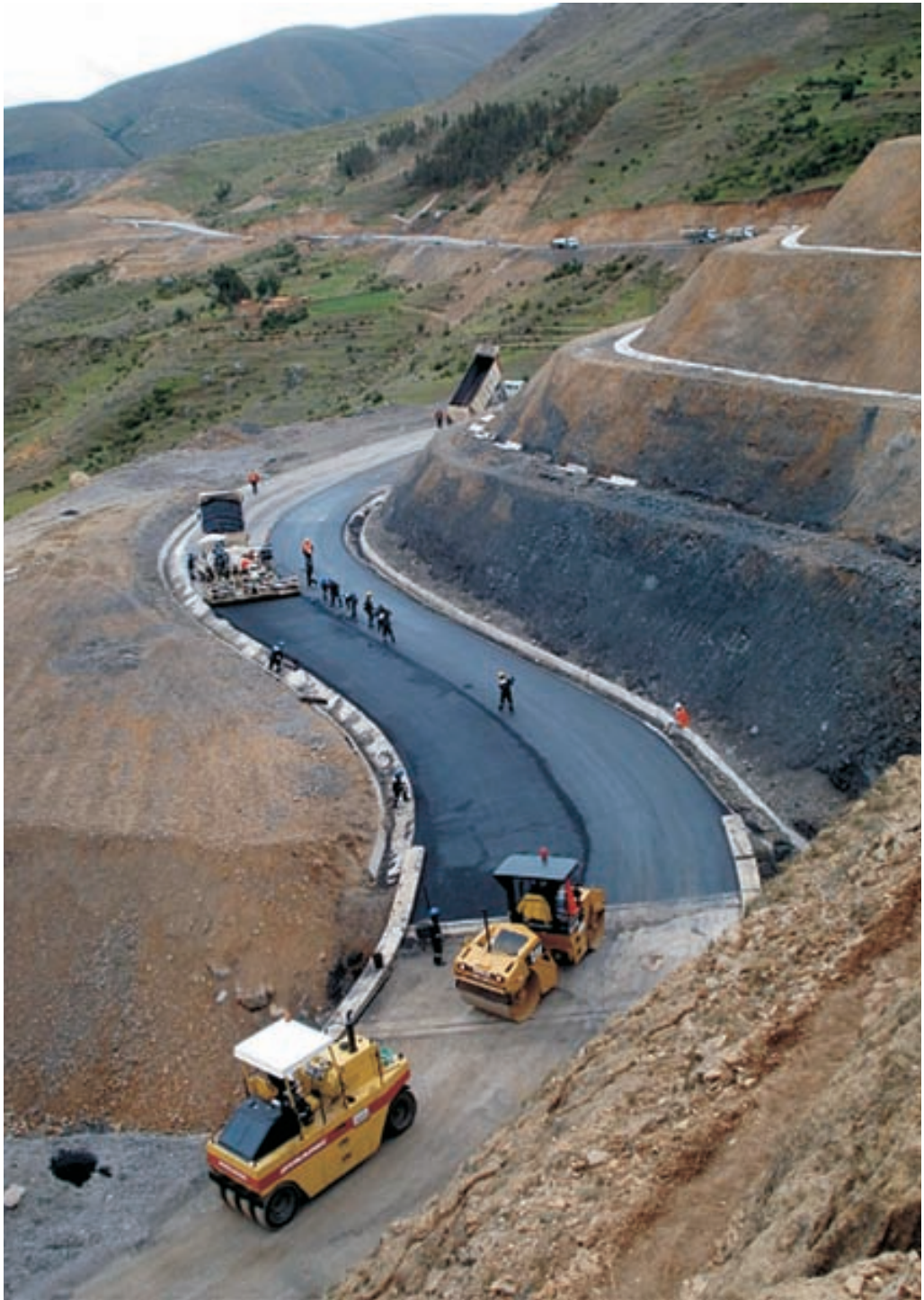
Obras en ejecución en Iirsa SUL, Trecho 2, en Perú
