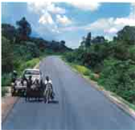
Carretera finalizada: obra de la empresa Andrade Gutierrez en el Congo
