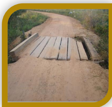
Figura 16 – Estrada utilizada pelo Transporte Escolar Rural - pavimento de cascalho.
