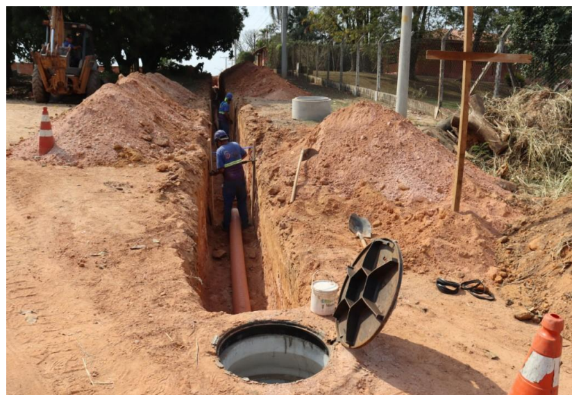
Figura 64 - Etapa de instalação e conexão dos tubos de esgoto nos poços de visita
