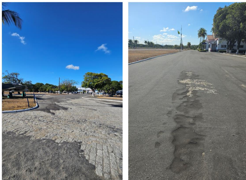
Figuras 39 e 40 – Sobreposição de asfalto
