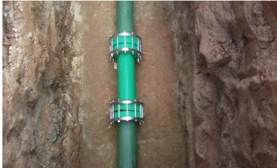
Figura 56 - Exemplo de reparo executado em trecho de tubulação
