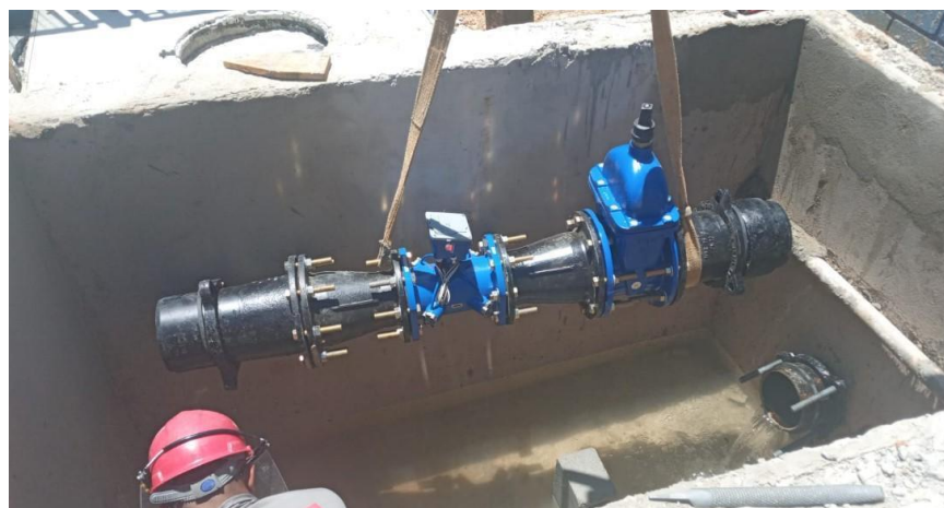
Figura 59 - Etapa de instalação de macromedidores
