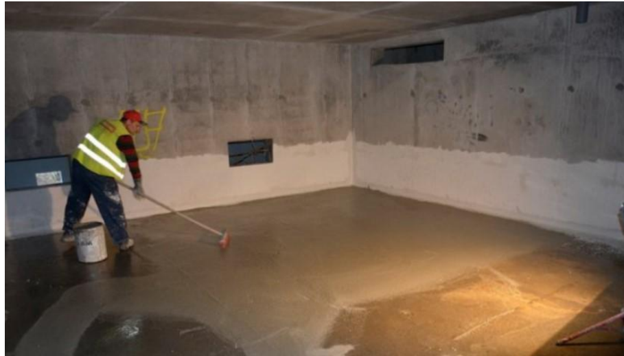
Figura 53 – Exemplo de impermeabilização de reservatório enterrado
