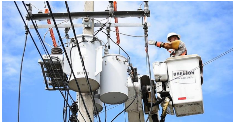
Figura 72 - Manutenção preventiva e corretiva de rede aérea.
