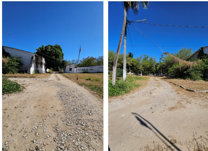
Figuras 43 e 44 – Vias não pavimentadas
