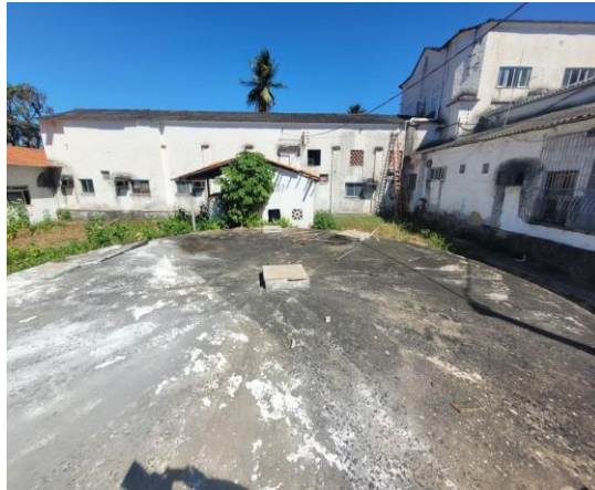
Figura 6 – Laje de cobertura do reservatório semienterrado
