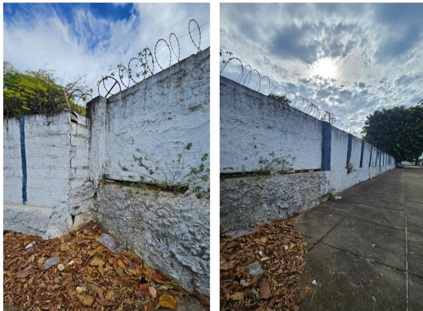
Figuras 49 e 50 – Vista externa de trecho do muro perimetral
