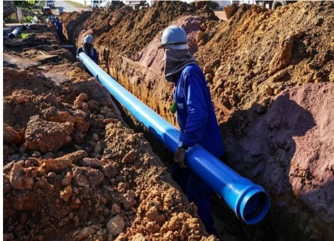
Figura 58 - Etapa de instalação dos tubos nas valas
