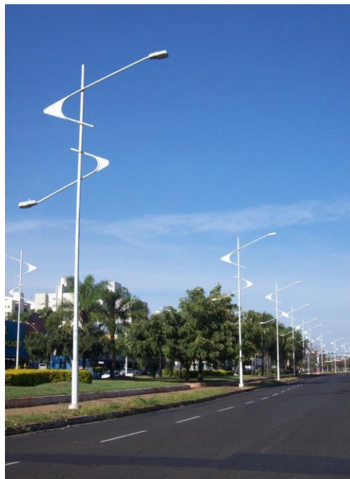
Figura 76 - Postes de iluminação pública com rede elétrica subterrânea
