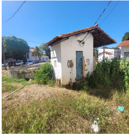
Figura 4 - Estação Elevatória de Água (E-007)
