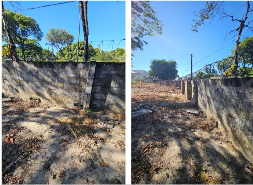
Figuras 47 e 48 – Vista interna muro perimetral
