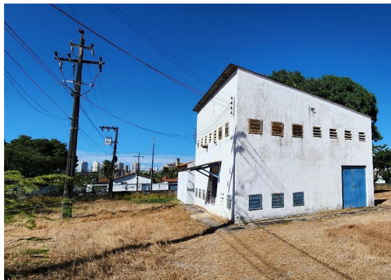
Figura 28 - Vista externa da subestação (detalhe do ramal de entrada e saída)
