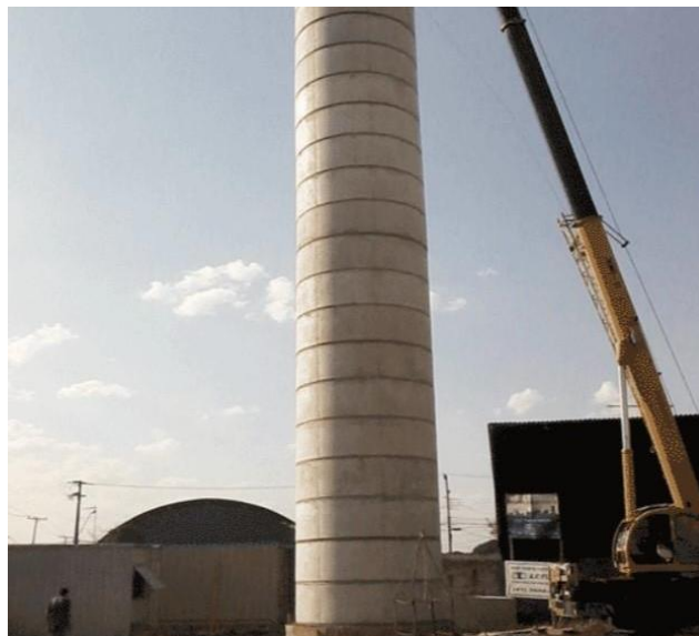
Figura 57 - Exemplo de Castelo D'água em concreto armado
