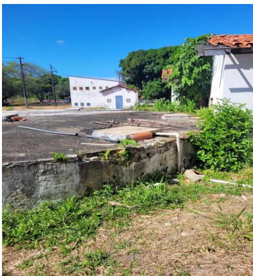
Figura 3 - Reservatório semienterrado de água (D-006)
