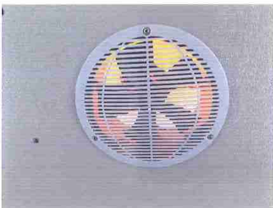
Figura 03 – Tomada de ar forçado
