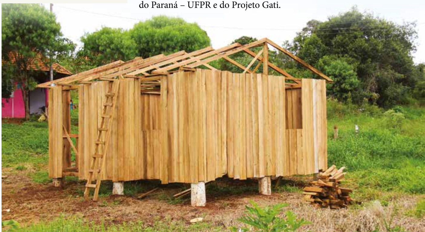
Construção de casa com madeira caída de pinheiro-do-paraná ( Araucaria angustifolia ) na Terra Indígena Mangueirinha
