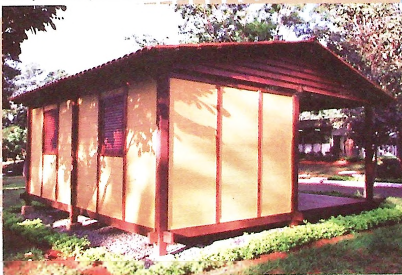
Protótipo de habitação em madeira
