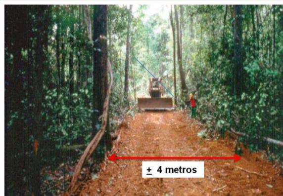
Figura 53 Nivelamento e acabamento de estrada secundária e terciária
