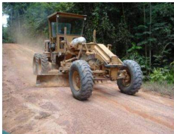
Figura 50 Abaulamento da estrada com motoniveladora
