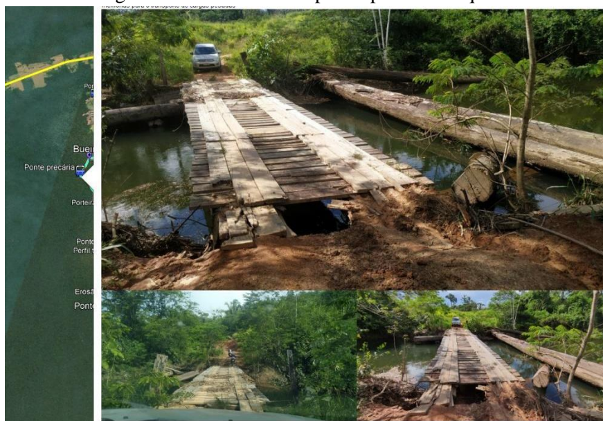
Figura 7. Acesso 1 - Exemplo de ponte inadequada.
