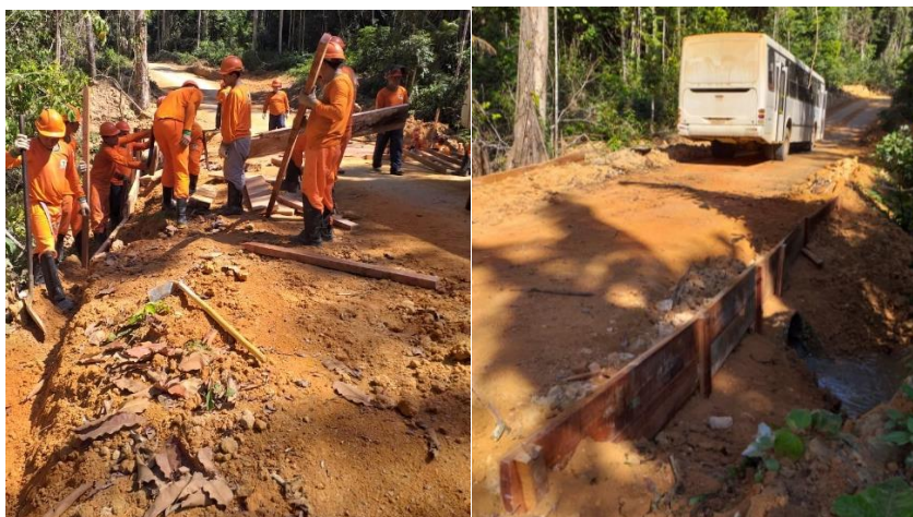
Figura 32: Construção de contenção nos bueiros
